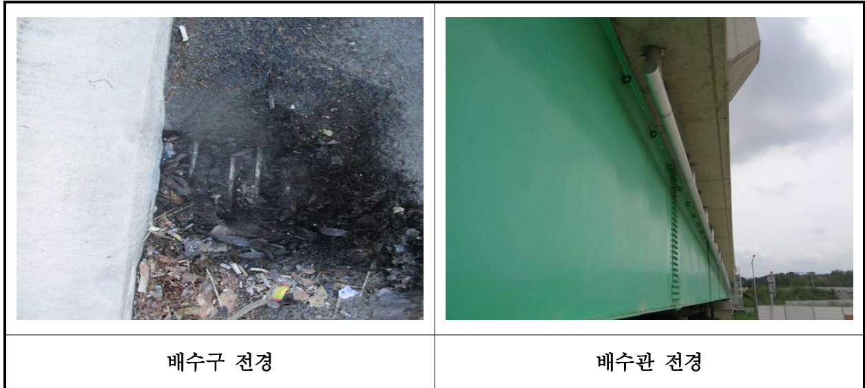
【사진 22.3.19】 배수시설 전경
