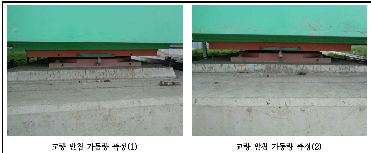
【사진 22.3.13】교량받침 이동량 측정
