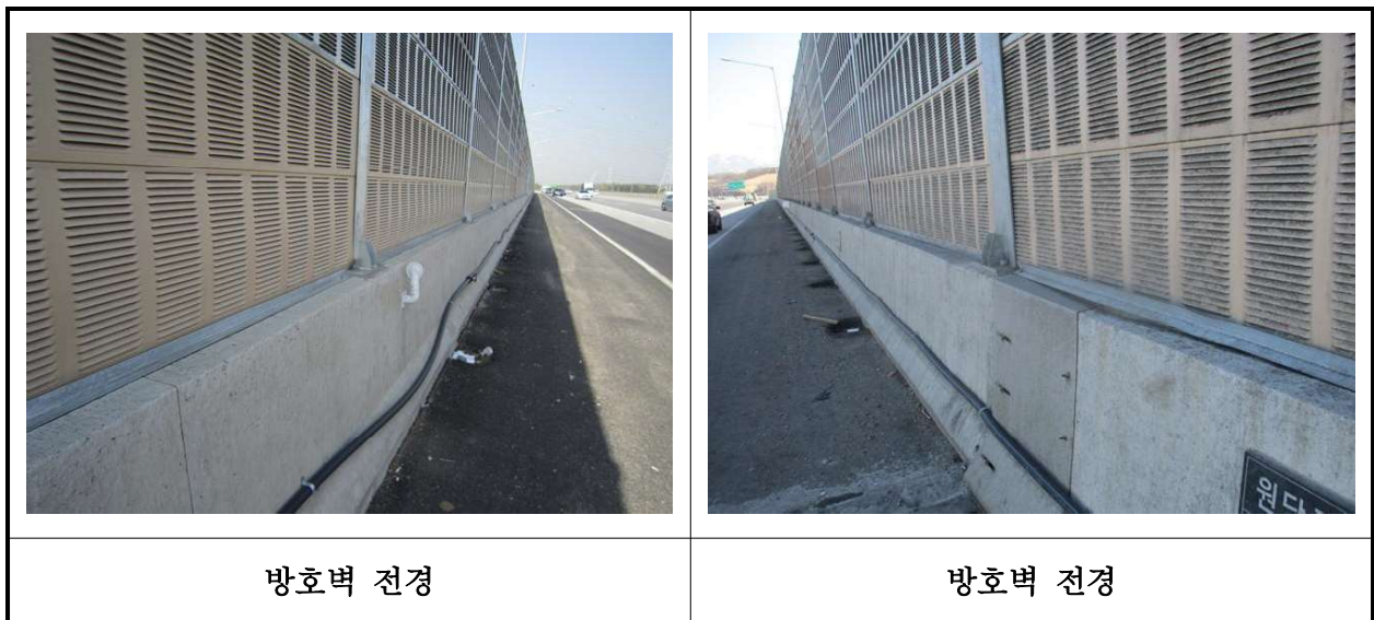
【사진 22.3.21】 방호벽 전경
