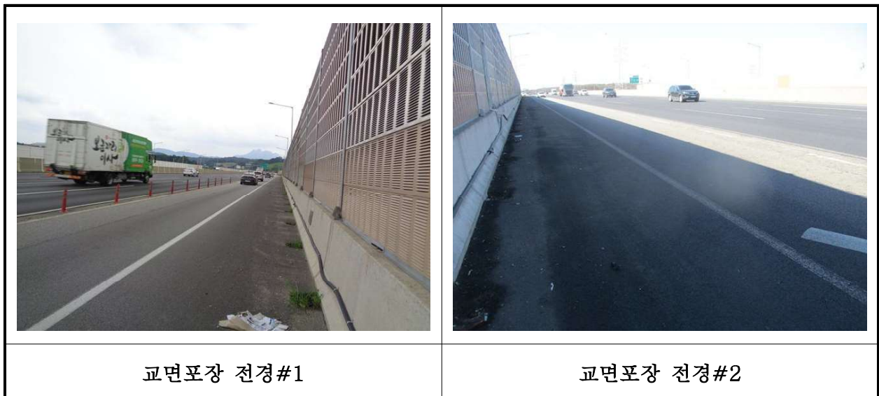
【사진 22.3.17】 교면포장 전경
