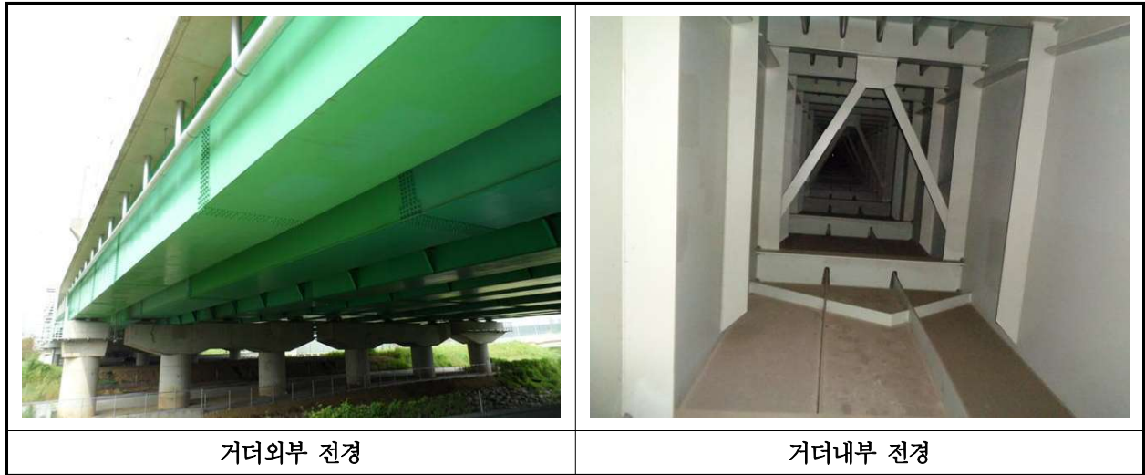
【사진 22.3.4】 거더 전경
