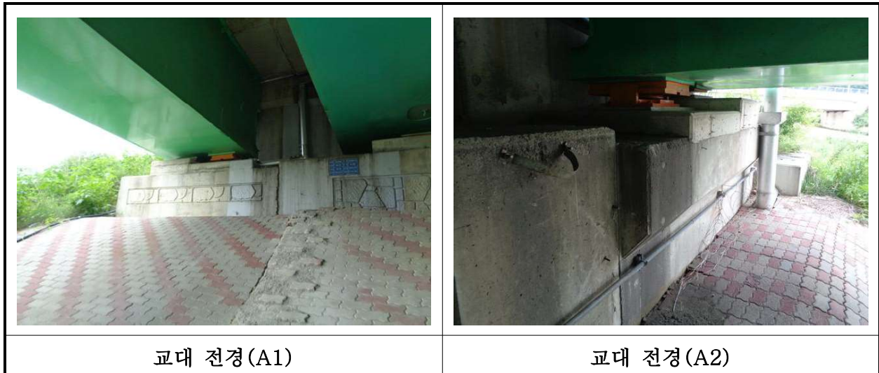
【사진 22.3.6】 교대 전경
