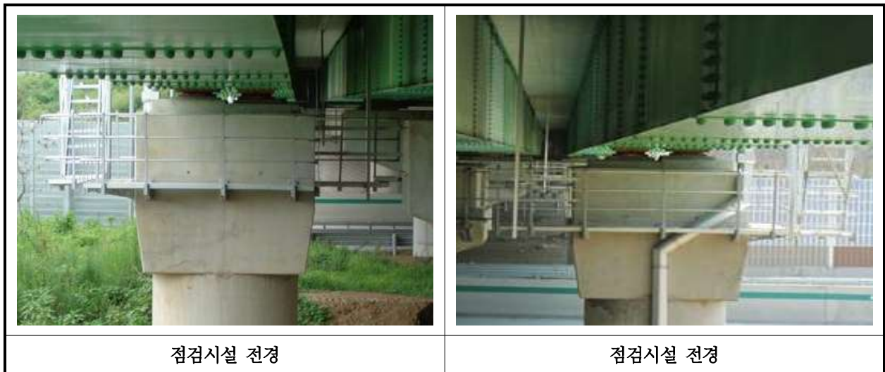
【사진 22.3.23】 교량 점검시설 전경
