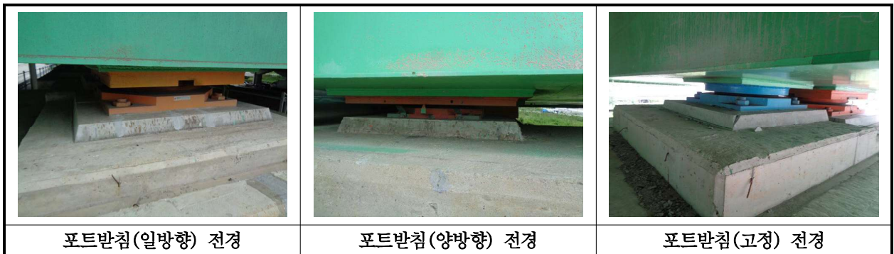
【사진 22.3.10】 교량받침 전경
