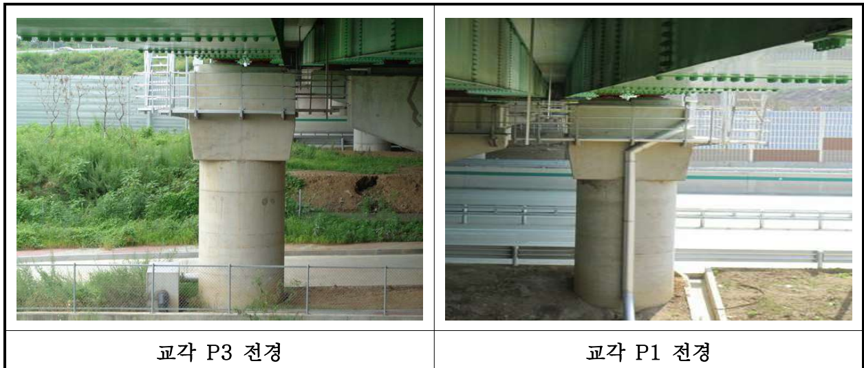
【사진 22.3.8】 교각 전경
