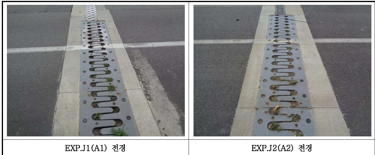
【사진 22.3.14】 신축이음장치 전경
